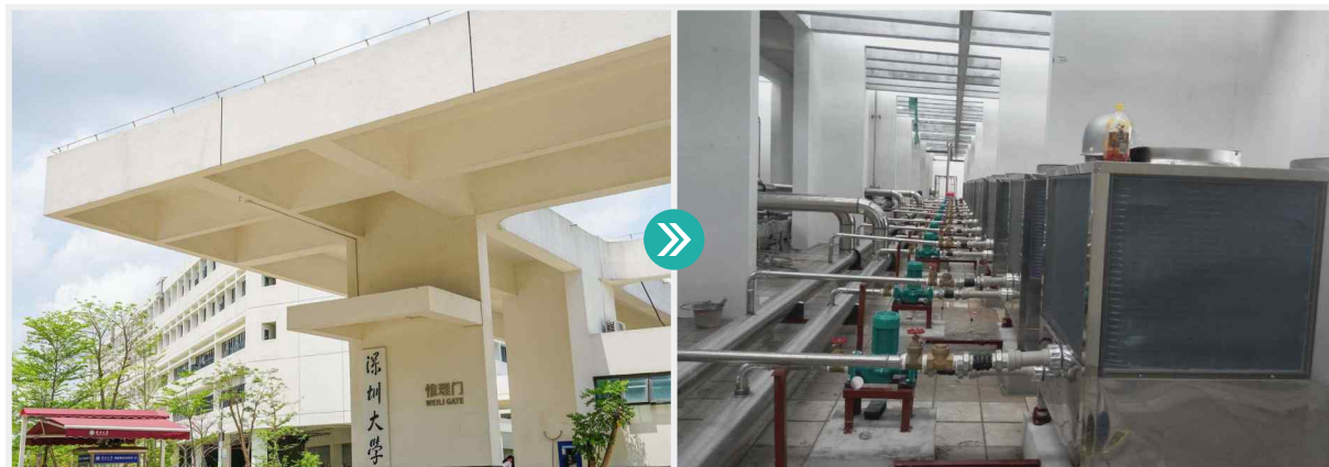
深圳大学城西丽校区 | 600吨水/天 | 型号: RB-36K 65台
